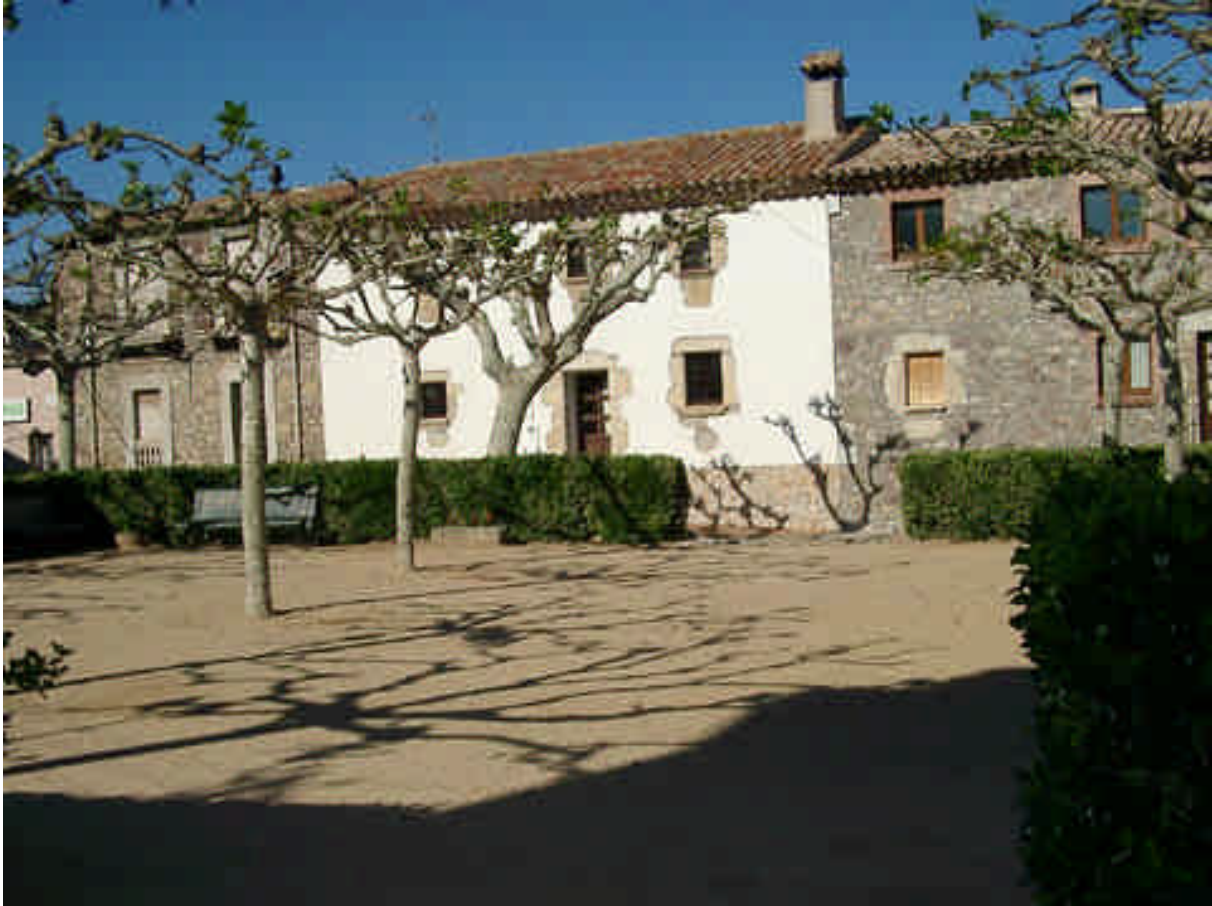
Abbildung 1: Westansicht des Hauses
